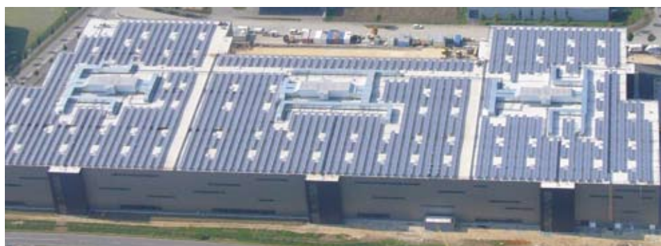
1 MW střešní zařízení, Holy-AG (Německo) 1 MW-инсталация, покривна инсталация, Holy-AG (Германия)
