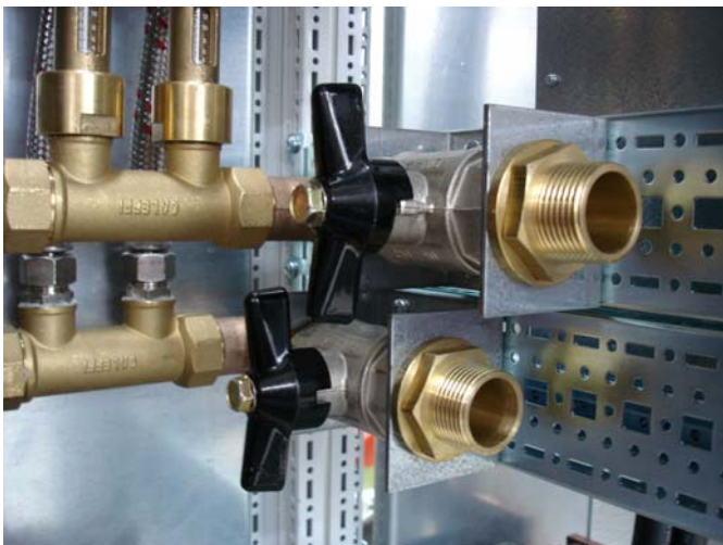
Abb.: 9 Anschluss Kühlkreislauf
